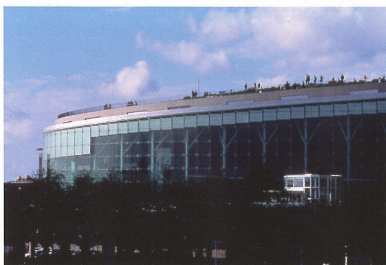
新潟市民芸術文化会館(1998年竣工)
