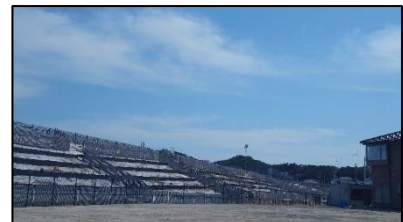
2020年3月陸側からみた防潮堤
