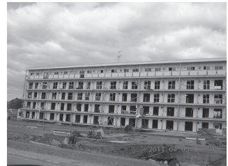
4階まで津波が押し寄せ、中が空っぽになったマンション。 4月3日陸前高田市
